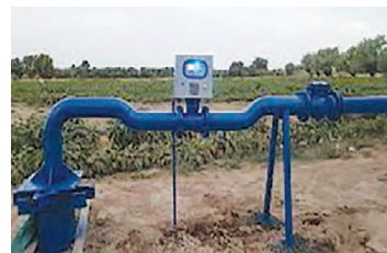
کنتورهای هوشمند، راهی برای اندازه‌گیری و کنترل برداشت از چاه‌ها
