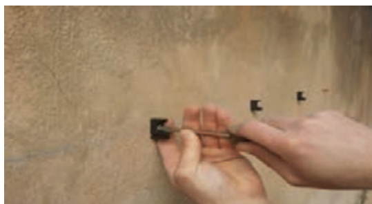
شکل ۳۶- نصب اولیه بست
