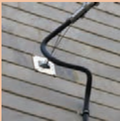
شکل ۵- نصب کابل به دیوار
