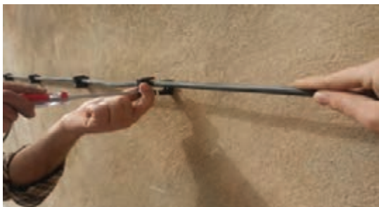
شکل ۳۷- کابل نصب شده روی دیوار
