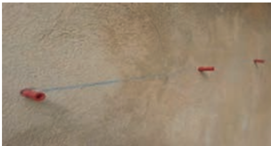
شکل ۳۵- نصب رول پلاک‌ها
