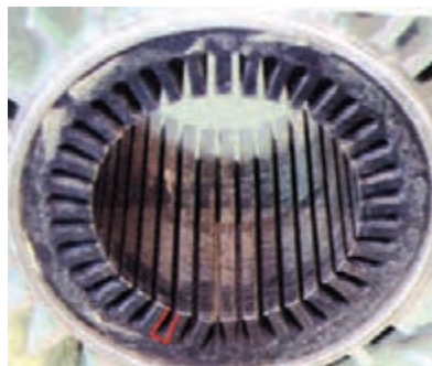
(الف) اندازه‌گیری سطح داخل شیار
