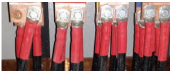
شکل ۱۷- عایق حرارتی کابلشو
