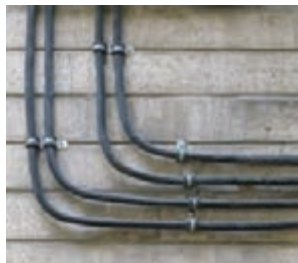
شکل ۲۱- خمش کابل
