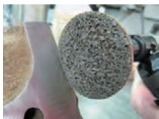
استفاده از دریل پنوماتیکی و سنباده کف گرد در رسوب زدایی محل نصب مانیفولدها
