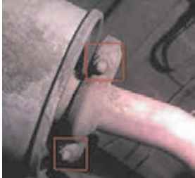
کنترل اتصالات لوله از صدا خفه کن
